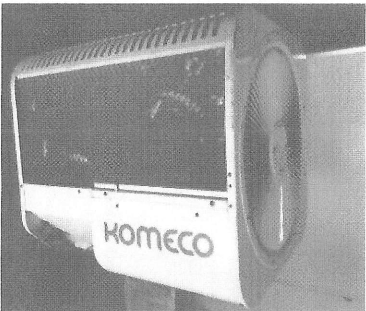
Unidade condensadora split 60000 BTUS marca KOMECO
